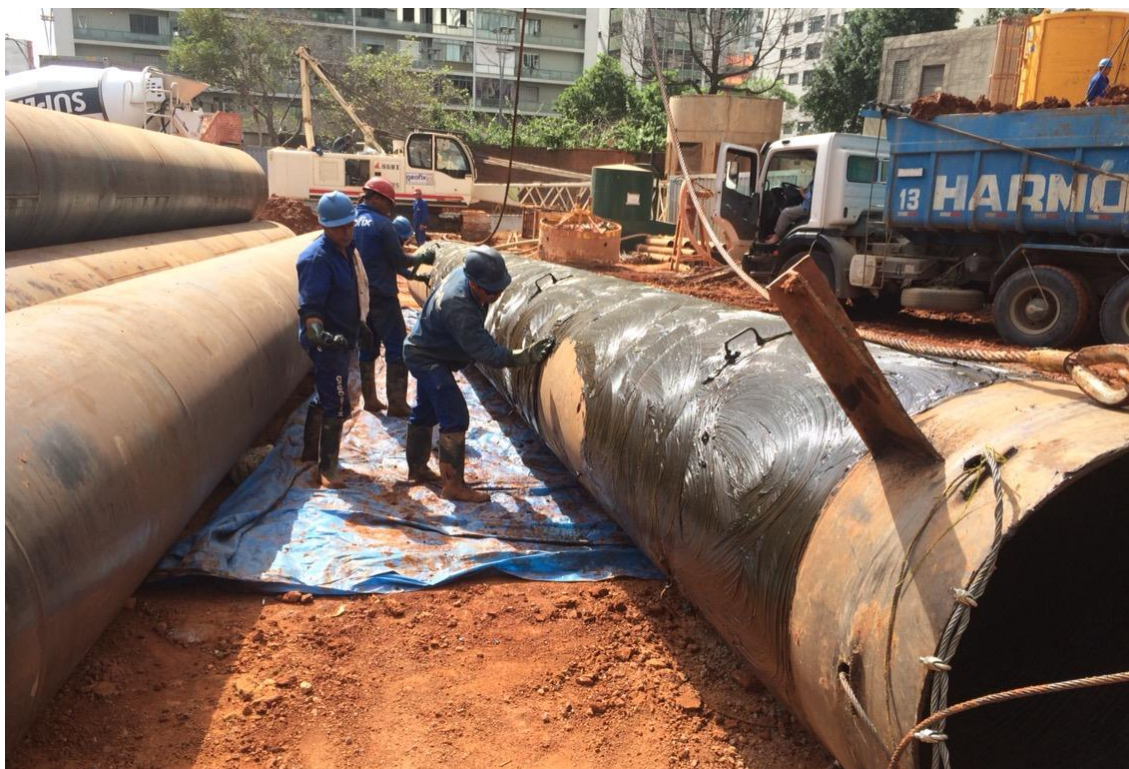
Foto 6 – Aplicação da graxa na camisa metálica
