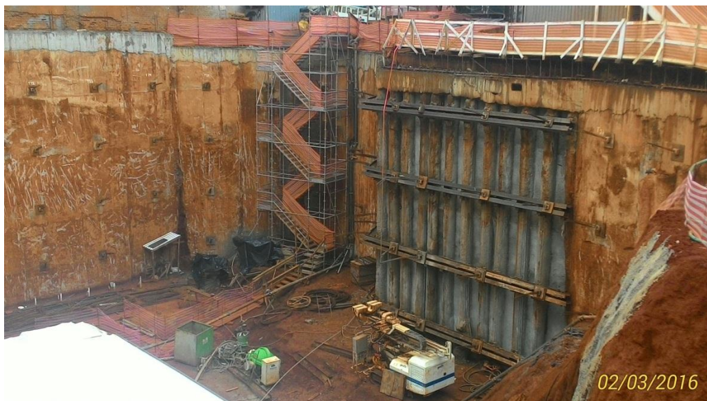
Foto 5 – Região da Contenção em Estacas tipo Hélice Contínua
