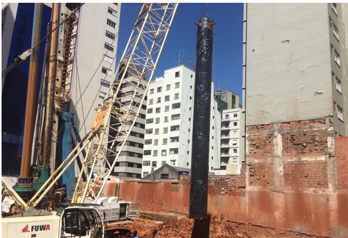
Foto 7 – Içamento da camisa metálica envolta com a lona plástica
