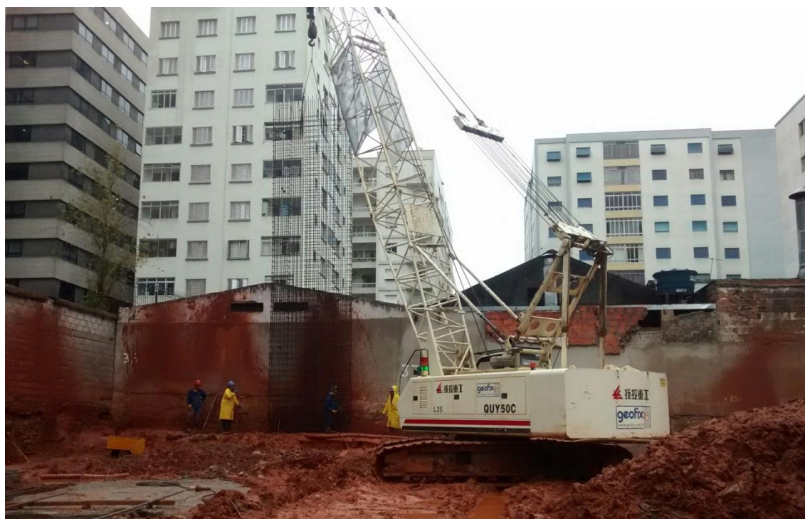
Foto 2 - Execução da Parede Diafragma
