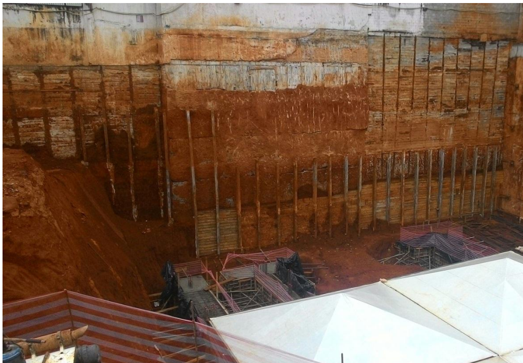
Foto 6 – Região dos Perfis Metálicos Implantados
