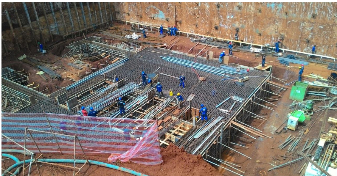
Foto 8 – Montagem do bloco central em andamento
