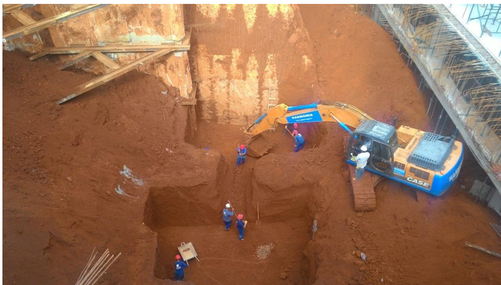
Foto 10 – Terreno de apoio das Sapatas
